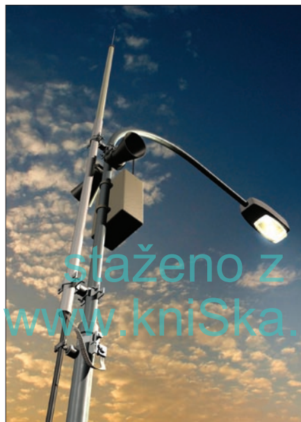
Obr. 8. Poplachový rozhlas na lampě v ochranném prostoru za pomoci DEHNcon H
