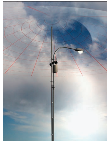
Obr. 3. Ochranný prostor kolem stožáru lampy
