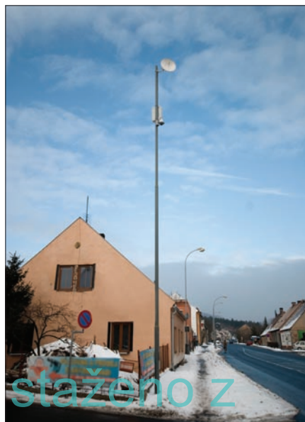
Obr. 2. Aplikace využitá jako jímáč pro ochranu objektu
