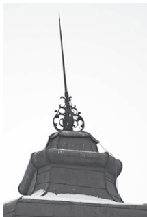
Obr. 1. J. T. Klinkoš 1775 – jímací tyč na zámku Nosticů v Měšicích u Prahy (foto: D. Šalanský)
