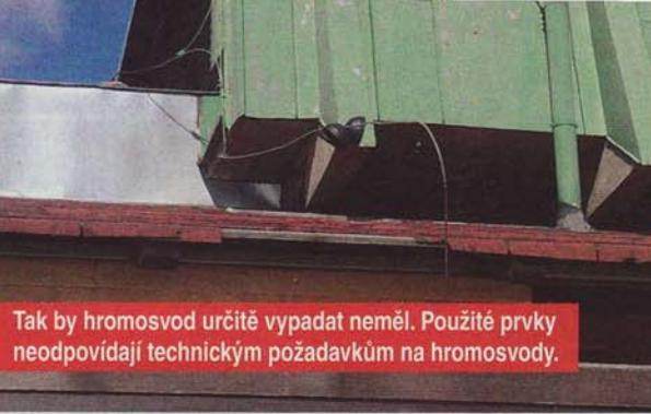
Tak by hromosvod určitě vypadat neměl. Použité prvky neodpovídají technickým požadavkům na hromosvody.
