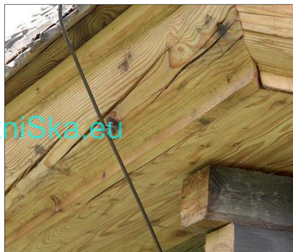
Obr. 1. Instalace svodu na dřevu
