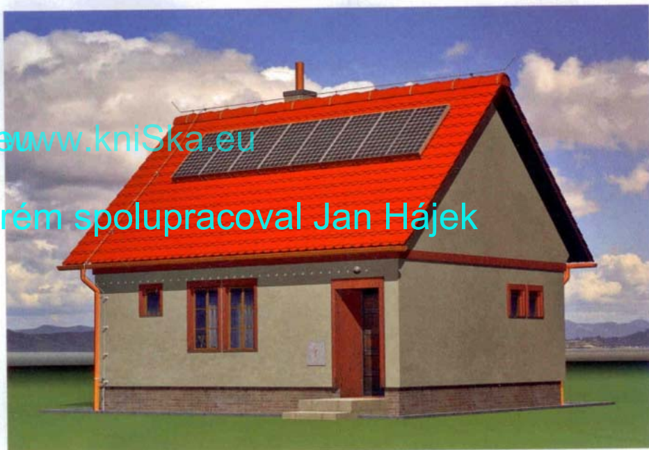
Kvalitně provedený hromosvod ochrání spolehlivě dům i jeho příslušenství, například solární kolektory (DEHN+SÖHNE)
