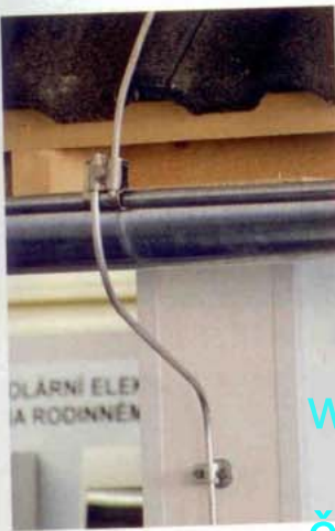
Správné připojení okapu k hromosvodu se obejde bez jejich poškození (DEHN+SÖHNE)
