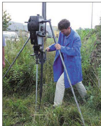
Obr. 14. Trojnožka pro zatlučování hloubkových zemničů
