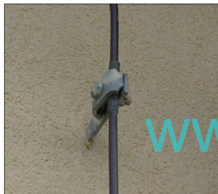
Obr. 6. Olověná vložka mezi pozinkovanou ocelí a mědí
